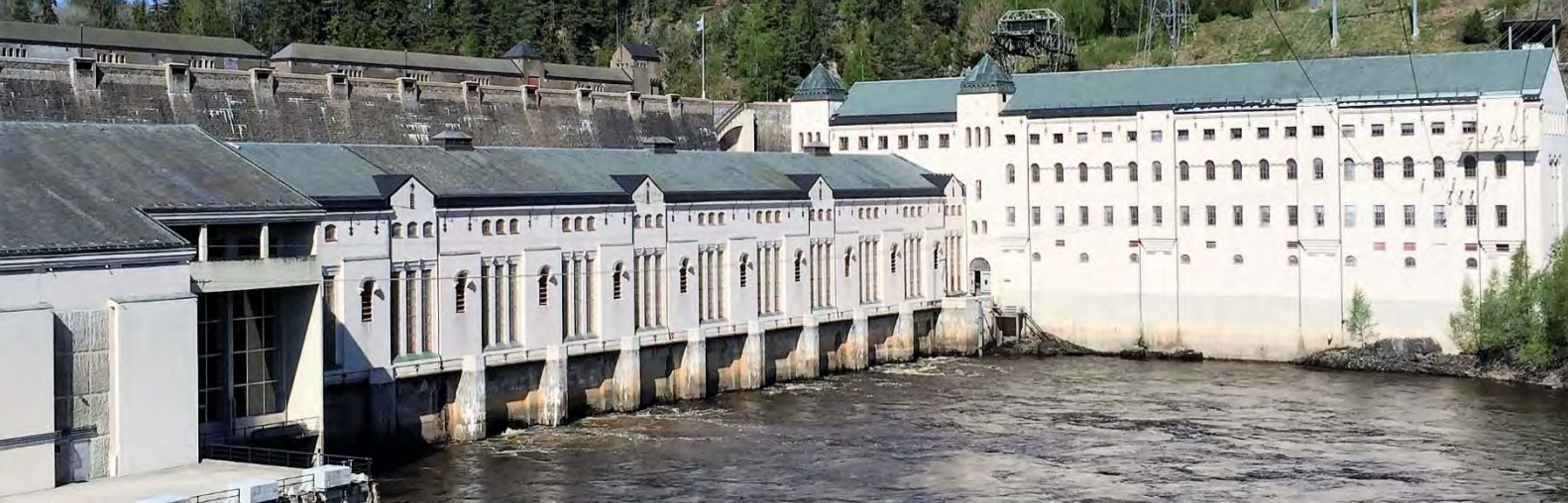
Vamma kraftstasjon. Foto: Torbjørn Østdahl/GLB.
