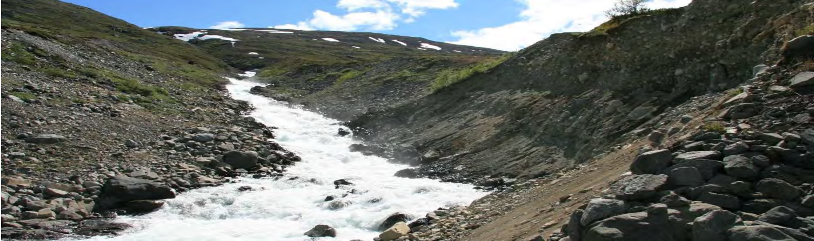
Svartholgrove i Smådalen, 200 m nedstrøms tunnelutløpet fra Veooverføringen. Det er laget plan for sikring og opprensning av strekningen ned til Smådalsvatni. Foto: Tore Sollibråten/GLB.
