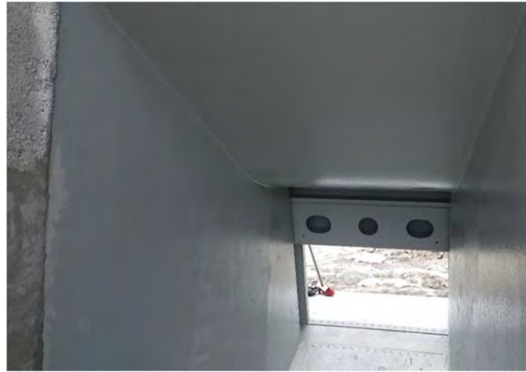
Sluttbefaring av lukerehabilitering, Raudalen. Foto: Rune Haug/GLB.
