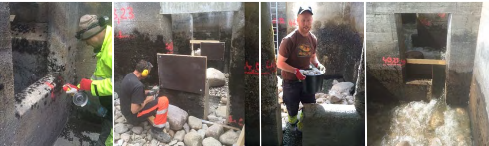
Ombygging av fisketrappa i Høyegga. Foto: Trond Taugbøl/GLB.
