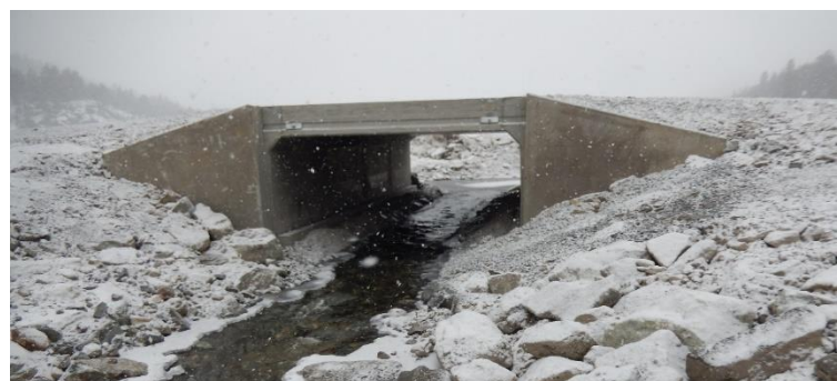
Ny betongkulvert ved Mogardsbekken. Foto: Rune Haug/GLB.
