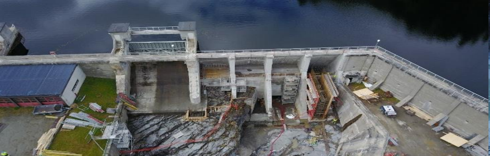
Ombygging av dam Olstappen, 15.september 2017. Foto: Fredrik Staff Edin/GLB.
