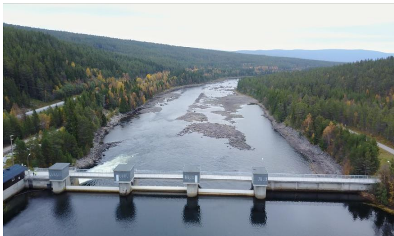
Dam Høyegga (overføringspunkt til Rena). Foto: Fredrik Staff Edin/GLB.
