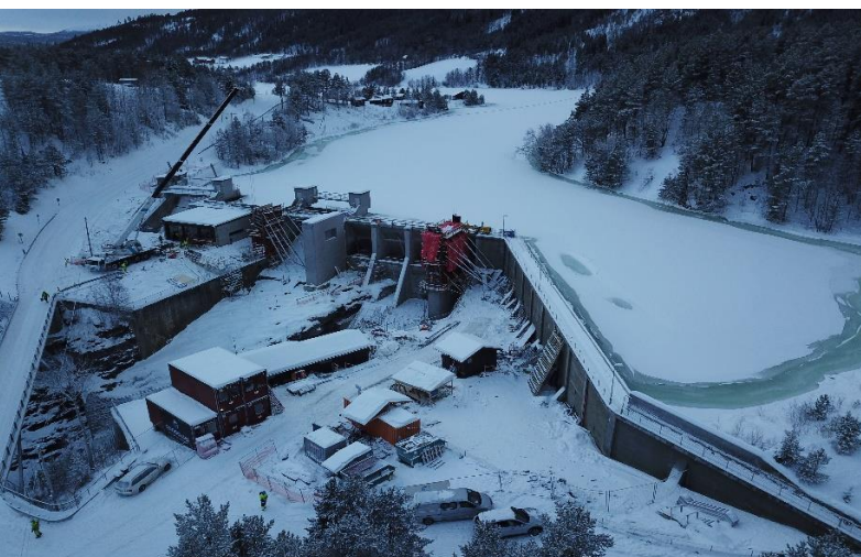
Ombygging av dam Olstappen høst/vinter 2017/2018. Foto: Fredrik Staff Edin/GLB.
