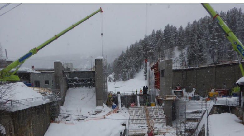
Lamelldammen i hele feltet hvor ny stor luke ble plassert, var ferdig fjernet 5. april. Foto: Steinar Sørлие/Eidsiva.
