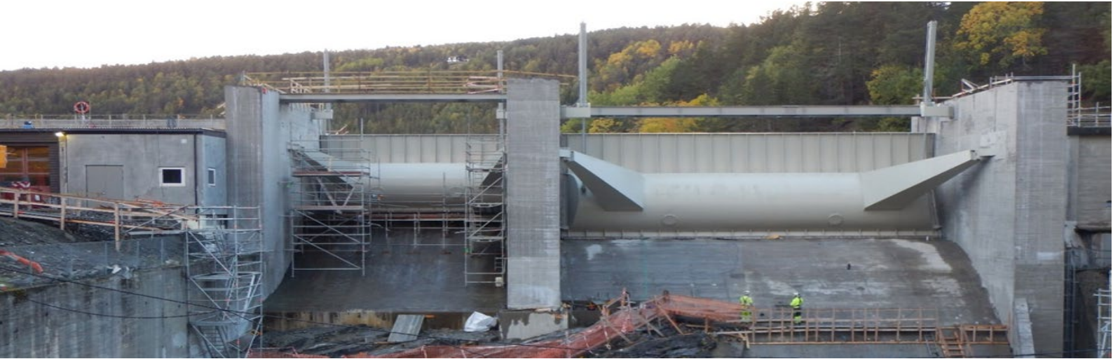
To nye segmentluker på plass ved Olstappen dam. Foto: Steinar Sørлие/Eidsiva.
