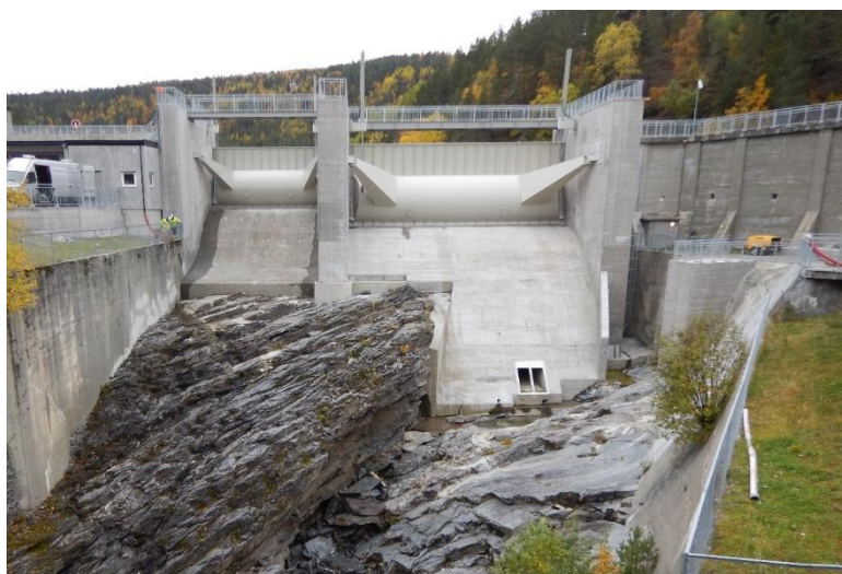
Dam Olstappen etter ombygging av luker. Foto: Steinar Sørлие/Eidsiva.
