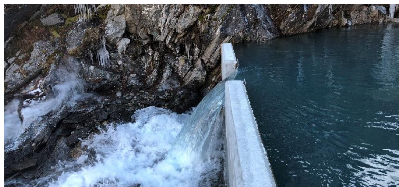
Bygging av ny målestasjon for minstetapping ved Raudalsvatn.
