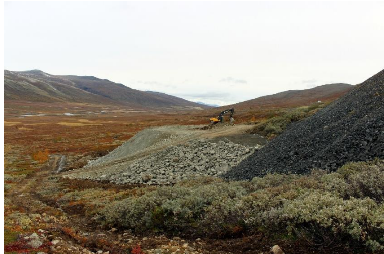
Overskuddsmasse fra utslaking av elveskråningen ble lagt i nytt deponi ved foten av eksisterende steintipp i Smådalen. Bildet viser deponiet før sluttarrondering og tilrettelegging for naturlig revegetering. Foto: Tore Sollibråten/Eidsiva.
