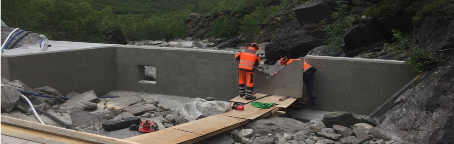
Nytt betongprofil for måling av minstevannføring nedstrøms Dam Raudalsvatn, ferdigstilt i 2019. Foto: Morten Brekkum/Eidsiva.
