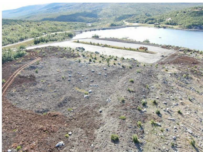
Breidaltippen etter tilførsel av masse. Foto: Amy Alnes/Eidsiva.
