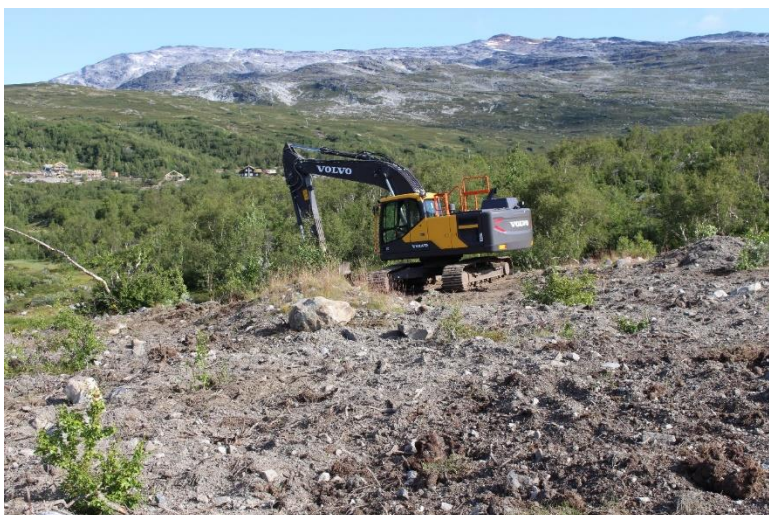
Tiltak på Breidaltippen 2019. Foto: Torbjørn Østdahl/Eidsiva.
