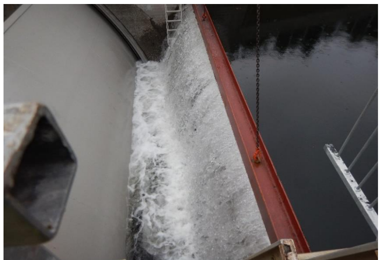
Bjelkestengselet oppstrøms sektorluka fjernes og vannet slippes kontrollert mot luka når bjelken i nivået med vannstanden tas ut. Foto: Steinar Sørлие/Eidsiva.
