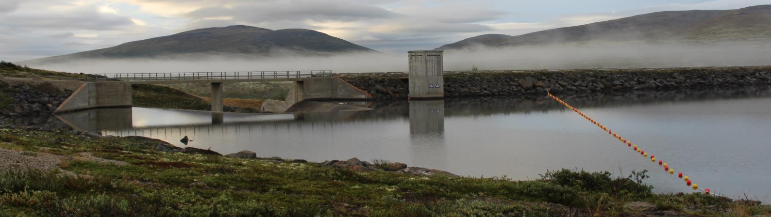
Dam Fundin. Foto: Tore Sollibråten/Eidsiva
