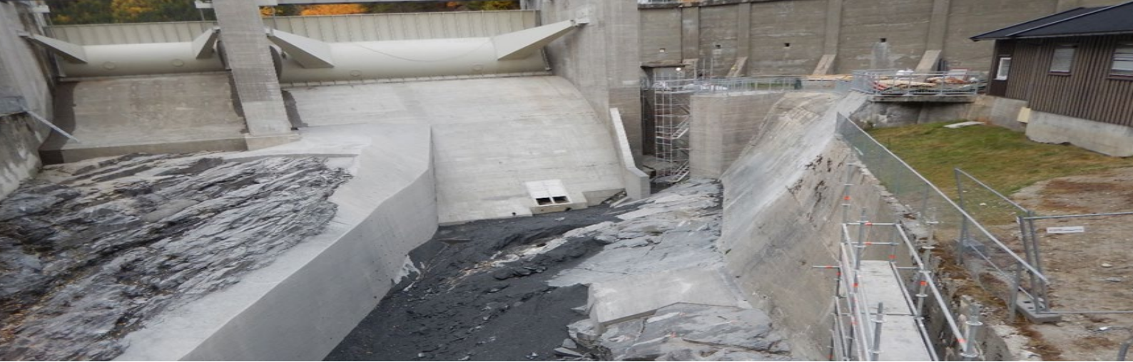
Olstappen dam. Ferdig støpt massiv betongvegg i flomløpet. Foto: Steinar Sørлие/Hafslund Eco.
