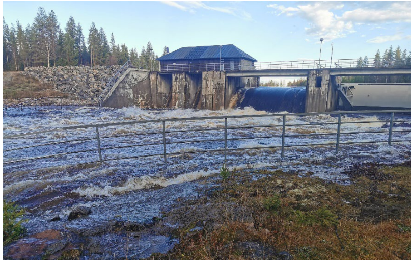
Høstflom Osensjøen 2. november. Forbitapping 175 m 3 /s. Foto: Jan Kristian Hagen/Hagen mekaniske.
