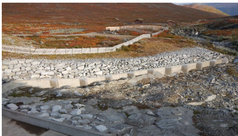
Aursjoen dam. Det ble støpt 10 stk betongstøtter på venstre ledemur nedstrøms dam. Foto: Steinar Sørлие/Hafslund Eco.
