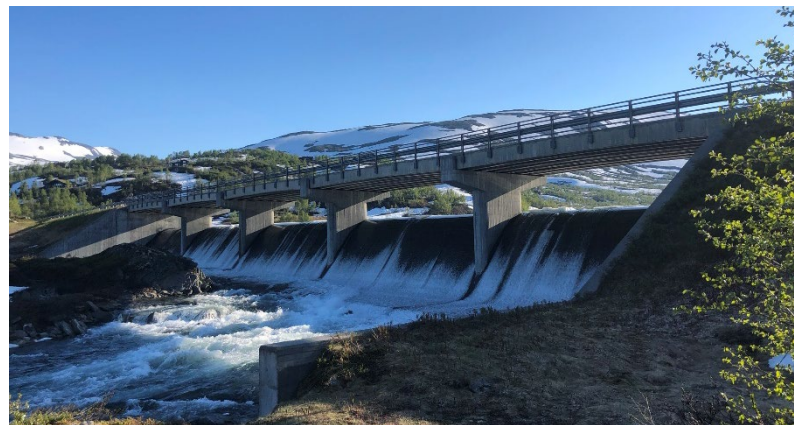
Breidalsvatn 26. juni, overløp over dam omtrent 15 m 3 /s, i tillegg omtrent 20 m 3 /s i forbitappingsluke.
