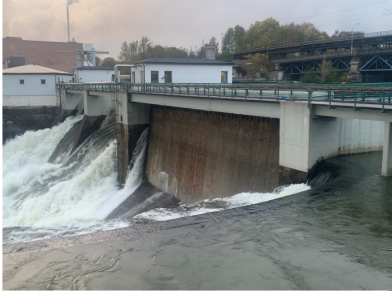
Havarett sektorluke ved Sarpsfossen. Luken kilt seg fast i betong på begge sider i østre og vestre pilar etter et ukontrollert løft. Foto: Nils Inge Lundheim/Hafslund Eco.
