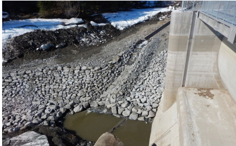
Dam Olstappen oppstrøms. Ferdig steinplastring av området og nytt løp for Kamsbekken inkl. terskel for sedimentering av masser. Foto: Steinar Sørлие/Hafslund Eco.
