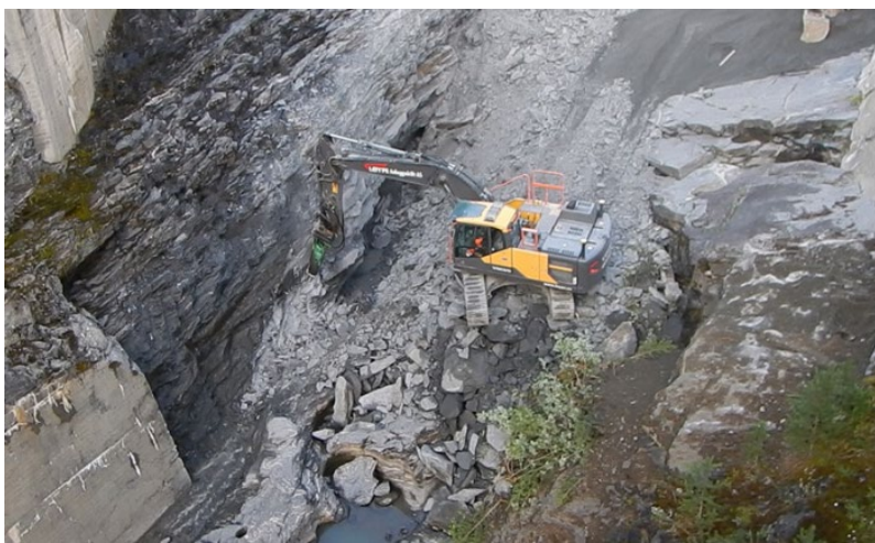
Olstappen dam. Pigging og rensk av dårlig fjell. Foto: Steinar Sørлие/Hafslund Eco.
