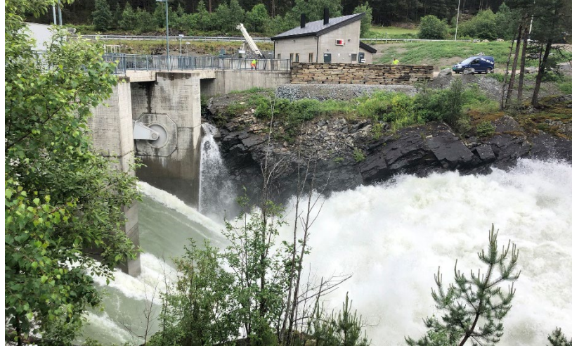
Eidefossen kraftverk i Otta nedstrøms Lalm ved flomkulminasjon 22. juni, omtrent 710 m 3 /s i lukene og vel 220 m 3 /s i kraftverkene (inkl. Nedre Otta kraftverk). Foto: Turid-Anne Drageset/Hafslund Eco.
