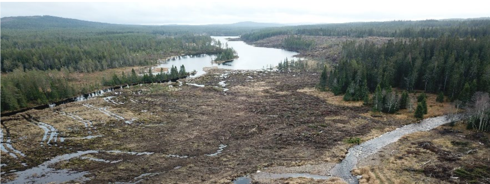
Rydding av neddemningsone mellom Håengsjøen og Håsjøen, september 2021. Foto: Fredrik Staff Edin/Hafslund Eco.
