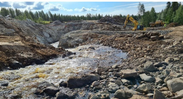
Omløpskanal der gravemaskinen holder på å renske fjellet hvor ny dam og inntak skal bygges.
