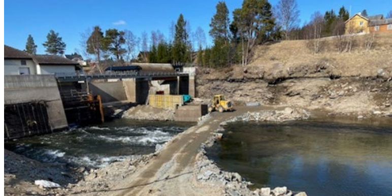
Anleggsveg over Glomma ved Røstefossen kraftverk, 9.mai. Foto: Terje Dalbakk/REN Røros Strøm AS.
