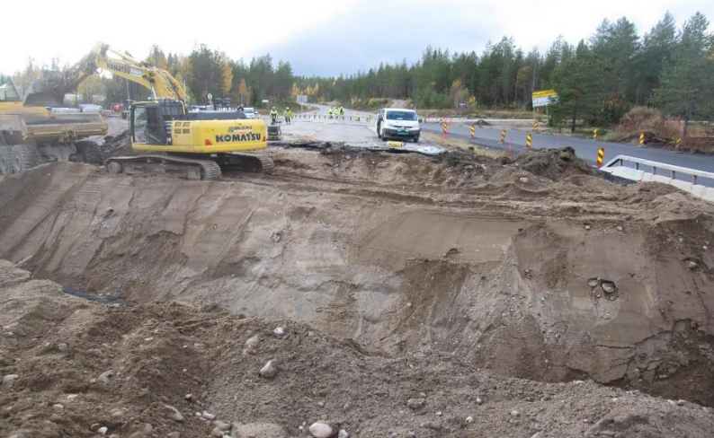
Kryssing av riksvei 25 med rørgata, september 2021. Foto: Kurt Magne Falling/Hafslund Eco.
