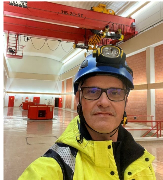
Befaring i Torpa kraftverk.
