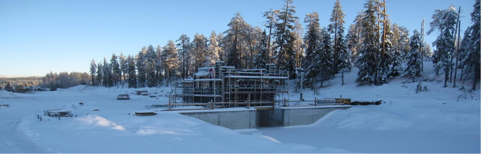
Overføring fra Øvre Flisa til Osensjøen- inntak Nordre Håsjøen, januar 2022. Arbeider med rørgata ses i bakgrunnen. Foto: Kurt Magne Falling/Hafslund Eco.
