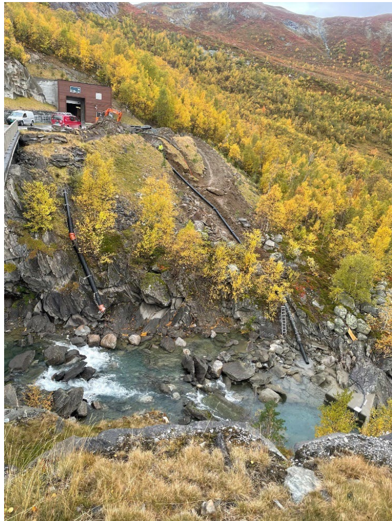
Tapperør fra Rauberget pumpestasjon før overfylling med stedlige masser. Nederste parti ble i tillegg omfylt med betong. Måledam for kontroll av det samlede minstevannføringsslippet sees nede i bildets høyre hjørne. Røret til venstre i bildet ble benyttet for midlertidig slipp av minstevannføring i forbindelse med bygging av måledammen i 2019 og er nå fjernet.
