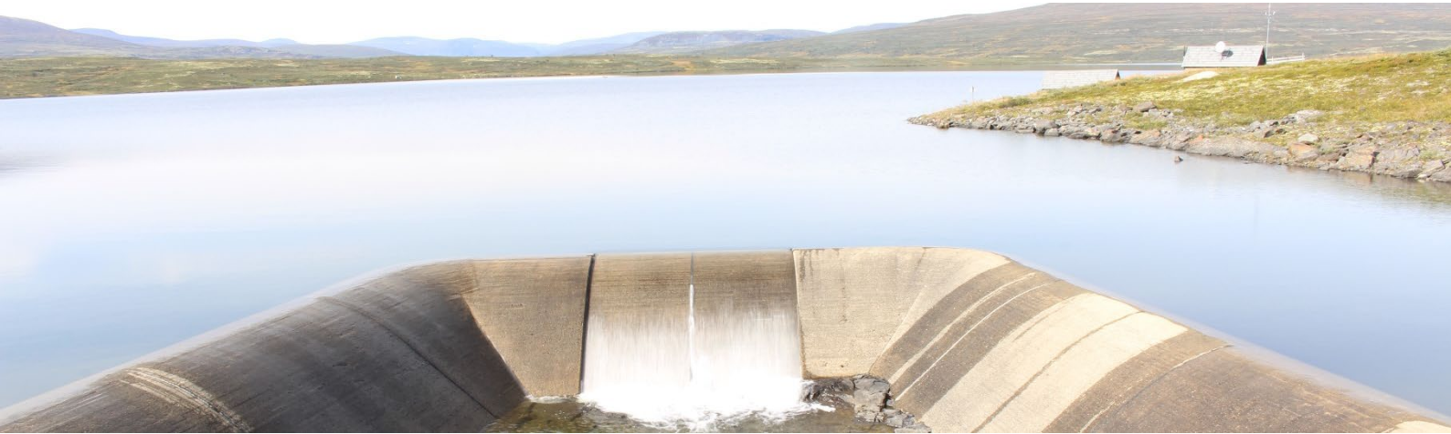
Fundindammen 30. august 2021. Foto: Tore Sollibråten/Hafslund Eco.
