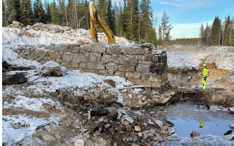
Dam Håsjøen nedstrømside, november 2021. Eksisterende dam var fundamentert på tømmer. Foto: Kurt Magne Falling/Hafslund Eco.
