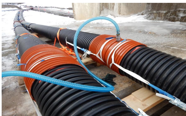
Bruk av vakumpumpe som sørger for kontinuerlig minstevannføring uten behov for diesel eller strøm. Foto: Steinar Sørli/Hafslund Eco.
