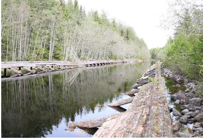
Treforbygningen slik den fremstod ved miljøtilsyn i 2021. Foto: Tore Sollibråten/Hafslund Eco Vannkraft AS.
