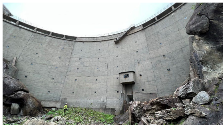
Dam Raudalsvatn, nedstrøms side.
