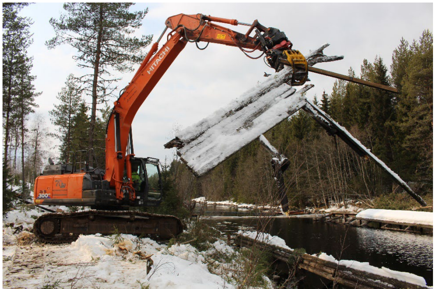
Under riving i mars. Foto: Tore Sollibråten/Hafslund Eco Vannkraft AS.
