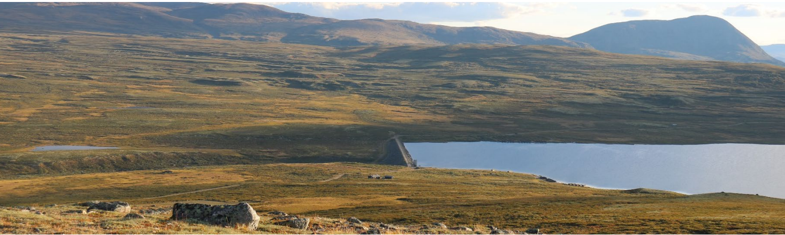
Dam Fundin. Foto: Tore Solibråten/Hafslund Eco Vannkraft AS.
