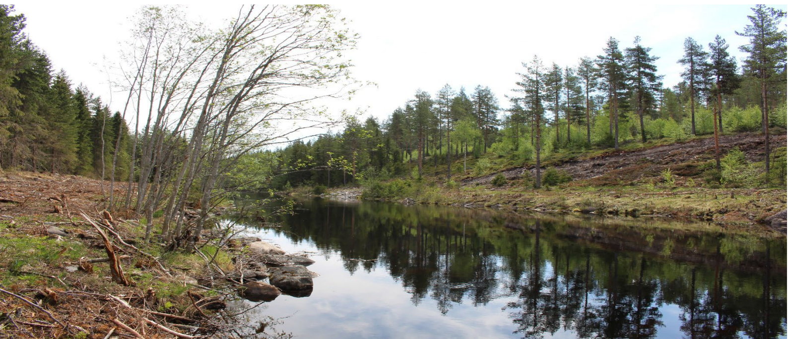
Søre Osa i juni, etter at arbeidet med fjerning av treforbygningen var utført. Foto: Tore Sollibråten/Hafslund Eco Vannkraft AS.
