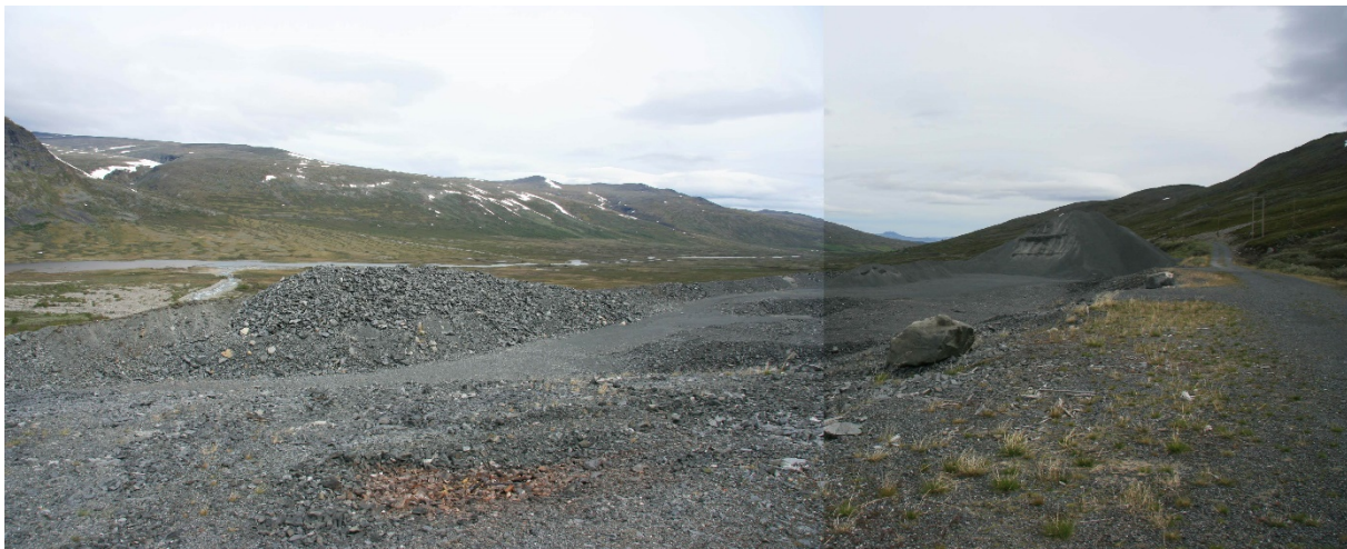
Figur 5. Vegen til høyre på bildet skal opprettholdes. Uttak og sluttarronding av skråningen mellom vegen og uttaksområdet skal prioriteres. Etterhvert som tippens minner som følge av uttak vil denne skråningen bli mer synlig fra områdene nedenfor tippens. For å redusere innsynet mot dette området når tippflaten senkes skal det opprettholdes en skjerm av masse mellom fronten av tippens og uttaksområdet.
