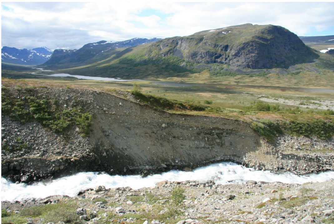
Figur 3. På et parti ca. 180 – 280 m nedenfor tunnelutløpet er det som følge av erosjon dannet en opp mot 20 m høy rasskråning, i planen benevnt som øvre erosjonsskråning . Herfra tilføres tappeløpet løsmasser som avsettes lenger nedstrøms.
