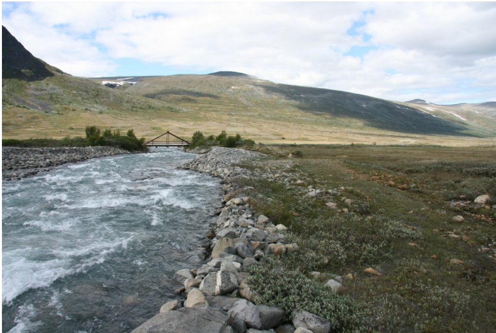
Figur 6. Oppstrøms gangbrua er det en strekning på høyre side hvor terrengforhøyningen mot tappeløpet er lav som følge av erosjon. Her planlegges det å reetablere kantsikringen for å bidra til at vannføringen følger hovedløpet.
