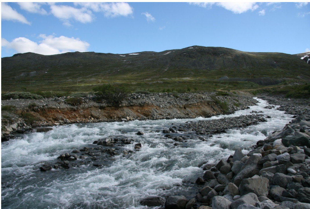
Figur 4. Over en strekning på ca. 60 m presser opplagrede ørmasser vannstrømmen ut mot kanten av tappeløpet og bidrar til erosjon i tappeløpets høyre bredd (sett ovenfra). Erosjonsstrekningen benevnes nedre erosjonsskråning og er lokalisert ca. 600 – 660 m nedenfor tunnelutløpet.
