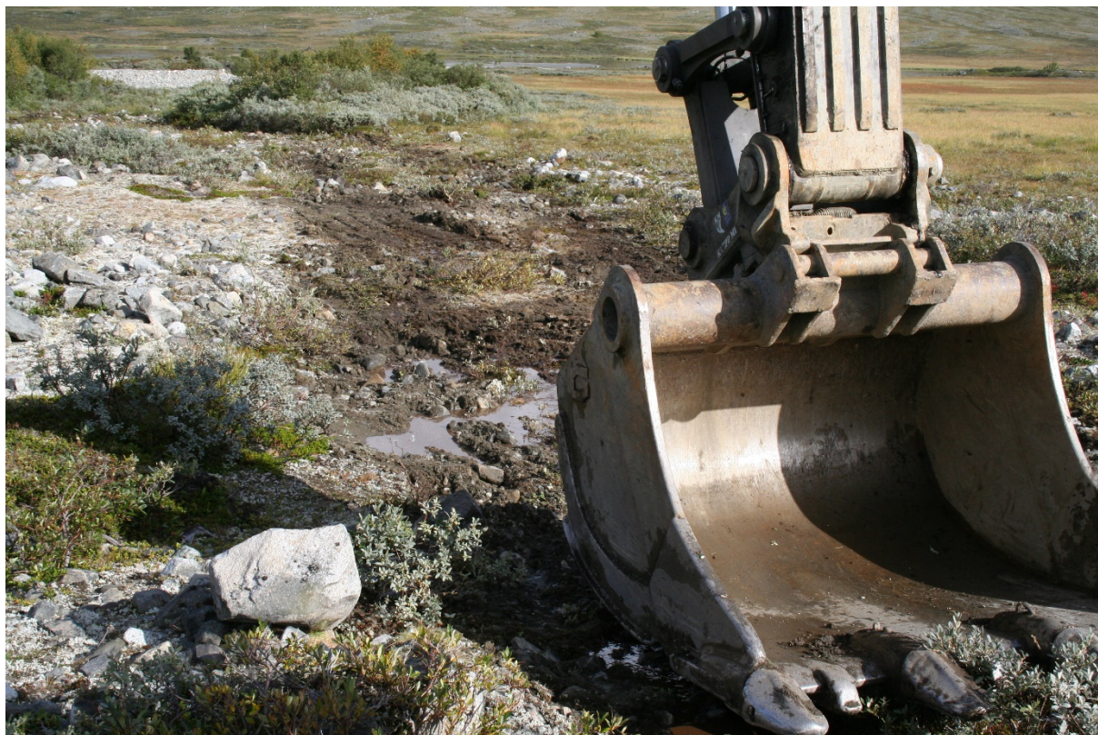
Figur 14. Så langt som mulig skal etablerte kjørespor langs tappeløpet benyttes. Bildet viser istandsatt kjørespor etter renovering av bru i 2011.
