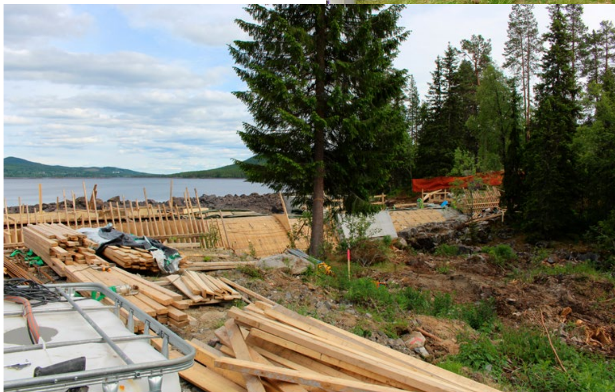
Dammen ved Nord-Mesna under ombygging i 2017.
