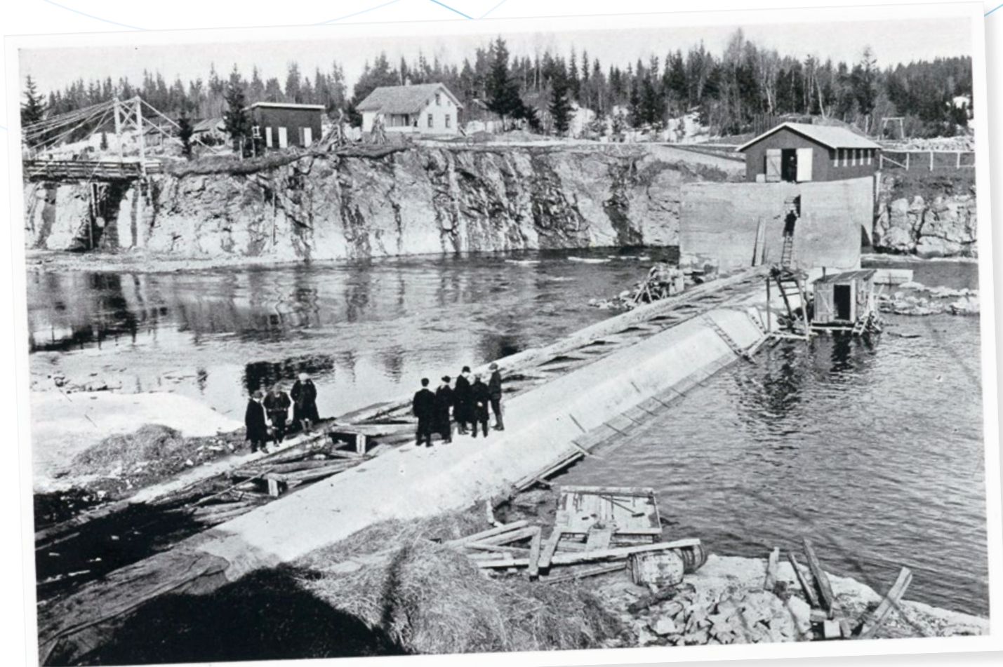
Bygging av Svanfosdammen i 1908.
