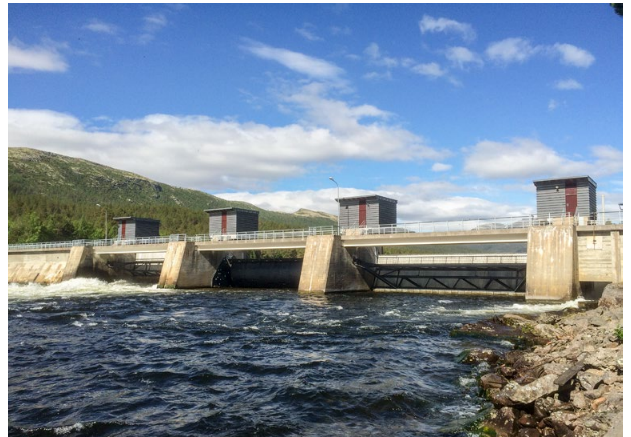
Høyegga – inntak for overføringen fra Glomma til Nordre Rena.
