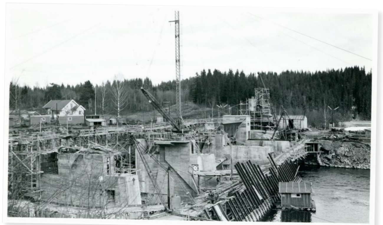
Ombygging av Svanfosdammen 1961.
