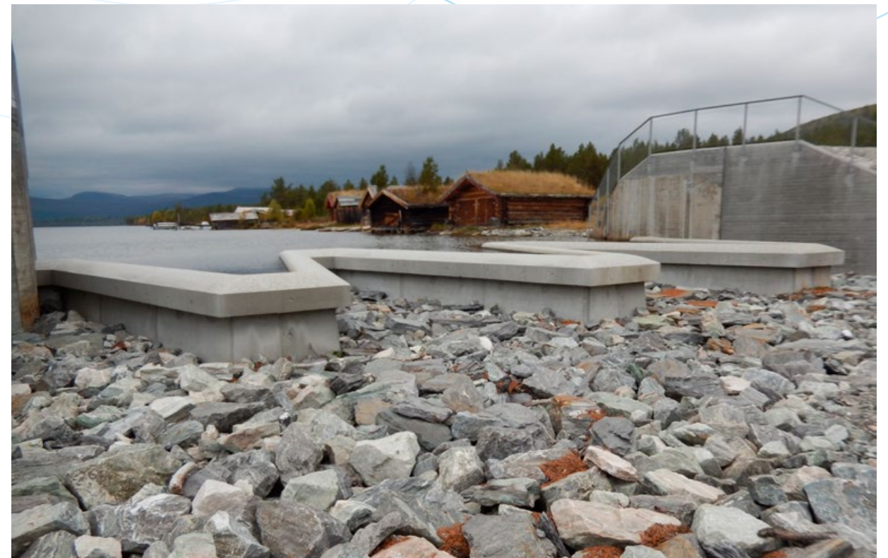
Reguleringsdammen ved Savalen ble rehabilitert i 2011.
