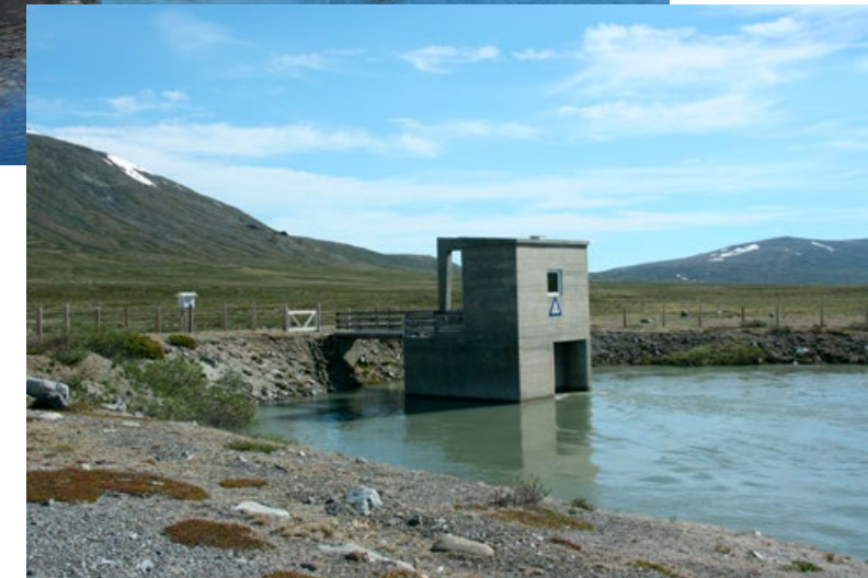
Inntaket til overføringstunnelen fra Veo til Smådøla.
