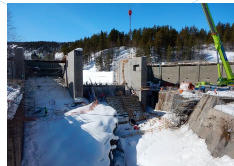
Dammen ved Olstappen under ombygging april 2018.
