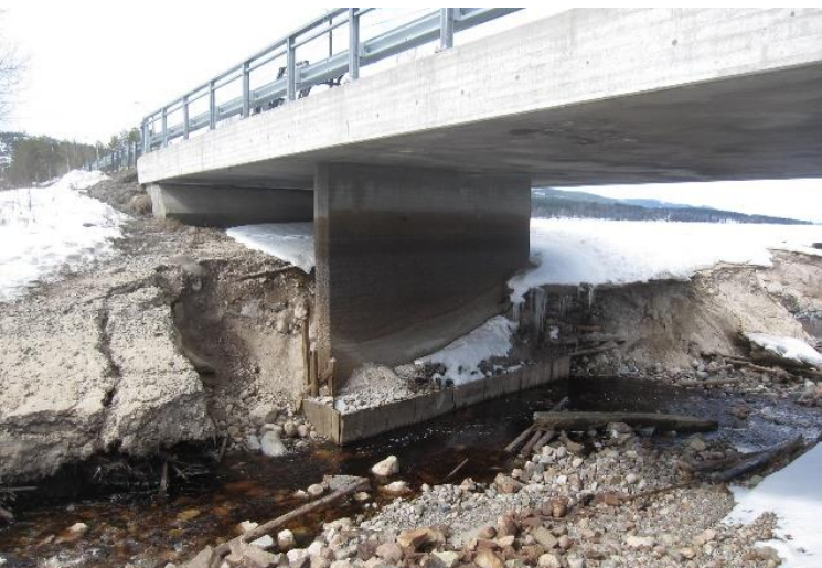
Erosjon ved brukar Søre Osen (venstre). Arbeid med sikringstiltak ved bru Søre Osen (høyre)
