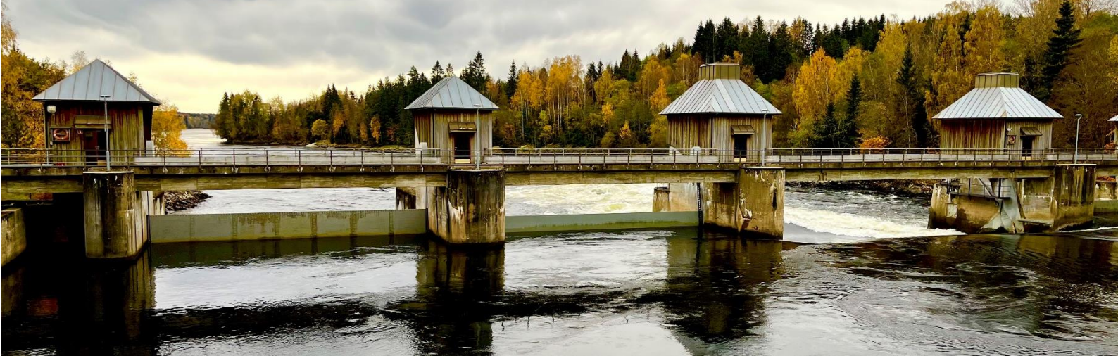
Dam Svanfoss. Foto: Camilla Dorthea Volnes/Hafslund Eco Vannkraft AS.
