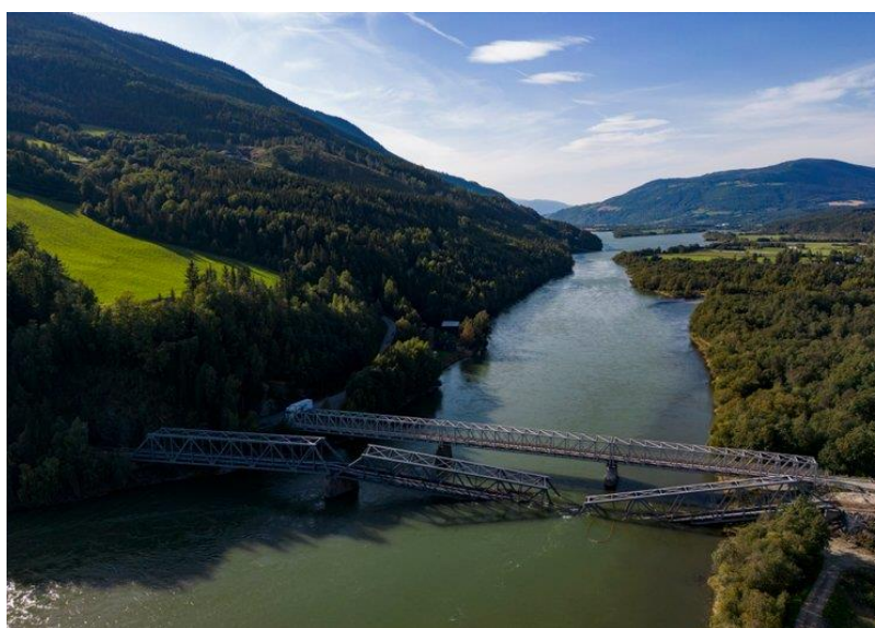
Randklev bru over Lågen ved Ringebu kollapset i augustflommen. Foto: Geir Olsen/NTB.
