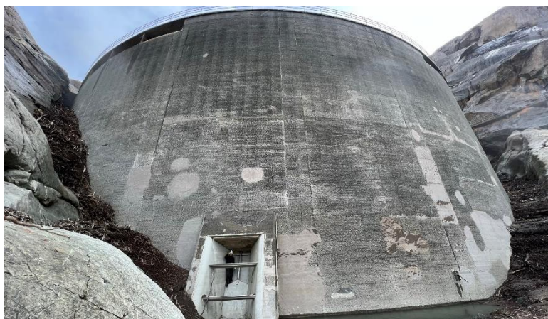
Raudalsdammens vannside. Foto: Rune Haug/Hafslund Eco Vannkraft AS.
