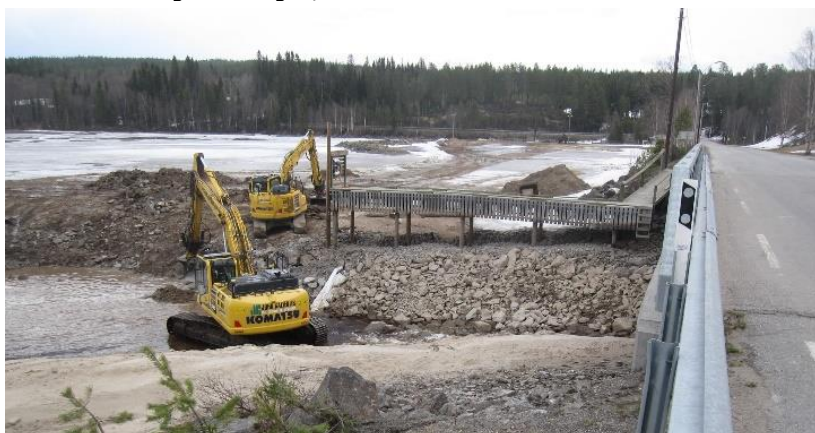
Erosjon ved brukar Søre Osen (venstre). Arbeid med sikringstiltak ved bru Søre Osen (høyre)
