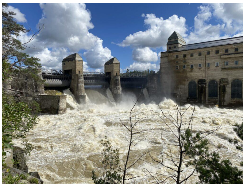
Forbitapping ved Solbergfoss kraftverk i august 2023. Foto: Rolf Steinar Engen, Hafslund Eco Vannkraft AS.
