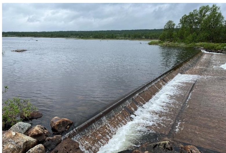
Terskel i Vinsterlonan i Vinstravassdraget. Miljøtilsyn i Vinstravassdraget i juni 2023 viste at anleggene som var gjenstand for tilsyn var i gjennomgående god tilstand.
