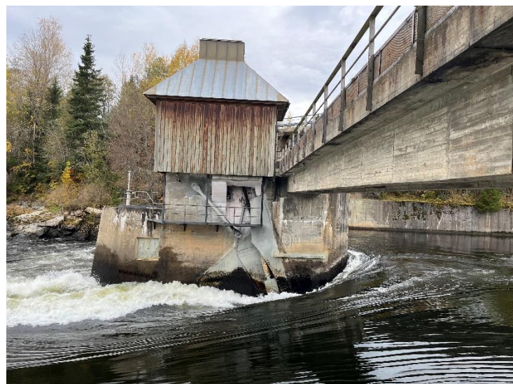
Dam Svanfoss. Foto: Camilla Dorthea Volnes/Hafslund Eco Vannkraft AS.
