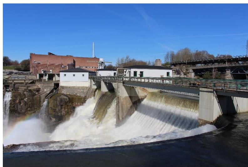
Forbitapping i Sarpsfossen 20.4.2023. Foto: Tore Sollibråten/Hafslund Eco Vannkraft AS.
